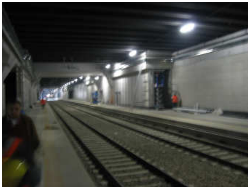
Nuova stazione Porta Susa interrata – binari di attestamento
