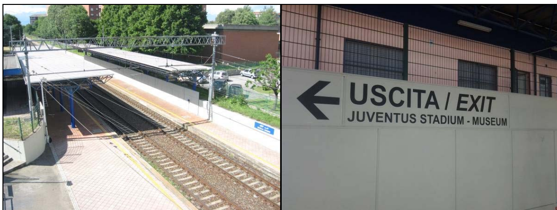
Figura 19 – Stazione Rigola Stadio, interventi di manutenzione e nuova segnaletica
